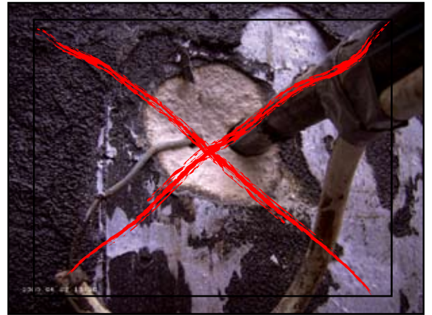
Nicht fachgerechte Einbindung der Gebäudeabdichtung
