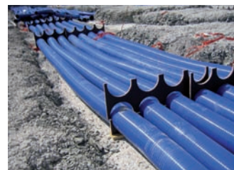
Abstandhalter zur Fixierung und Positionierung von Kabelschutzrohren.
