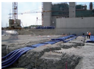
Kabelschutzrohrtrasse für KES-M 150, später mit 6 m Betonüberdeckung.
