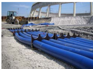
Verlegen der Kabelschutzrohre mit Hateflex 14150.
