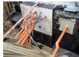
Ansicht betonierte Wand Zweites Aufmaß nach dem Betonieren und dem Verlegen der Bitumenbahnen.
