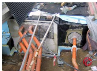
Kellerbereich Montage der Fest-/Losflanschkonstruktion.
