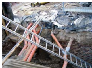
Ansicht Mauerwerk Erstes Aufmaß vor der Sanierung.
