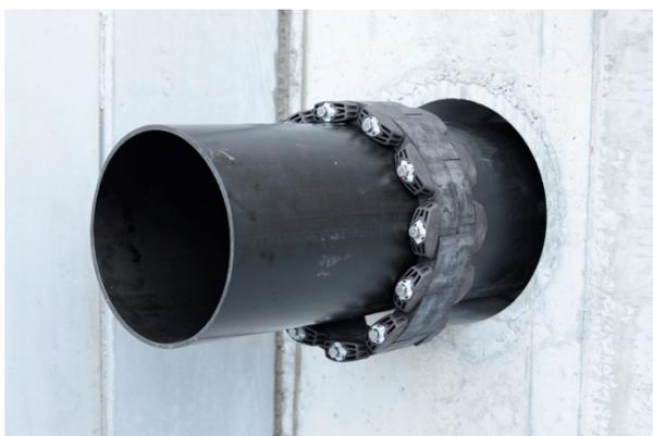
Hauff模块化密封装置的模块化系统只使用12个不同的模块尺寸，通过改变模块角度，可密封直径48.3到3000毫米的管道以及19.5到98毫米的圆形间隙进行气密性密封。
