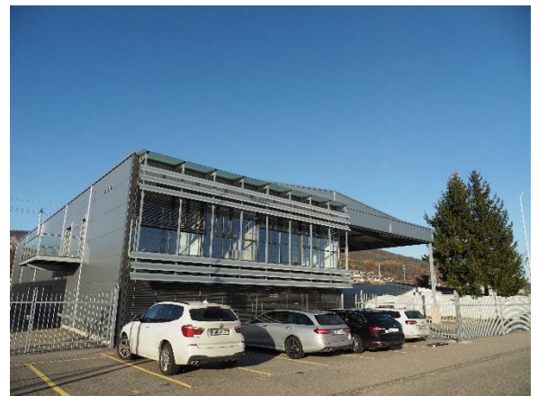
Il nuovo edificio aziendale dell'impresa Hauff-Technik Swiss AG con sede a Oensingen
