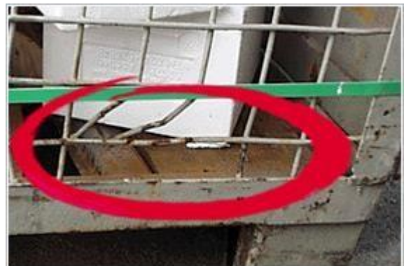
Abbildung 26: Gitterbox- Rundstahlgitter gerissen
