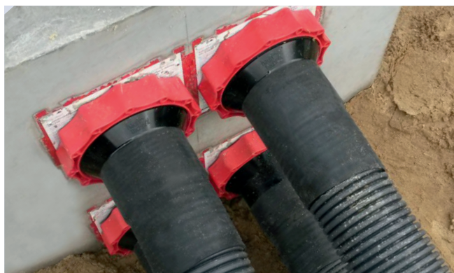
Anschluss von gewelltem Kabelschutzrohr an HSI 150 Einfachdichtpackung
