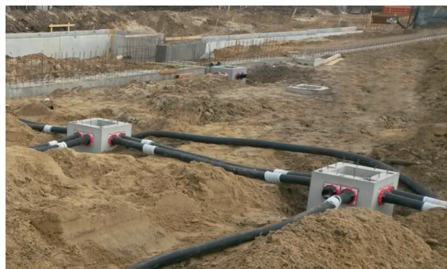
Leerrohrverbindung von Schacht zu Schacht mit jeweils Systemdeckel HSI 150 – D110 KS
