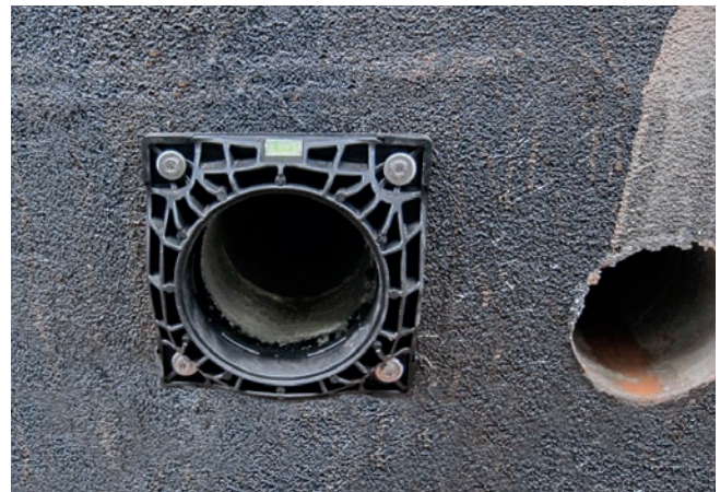
HSI 150-DFK Kunststoffflansch
