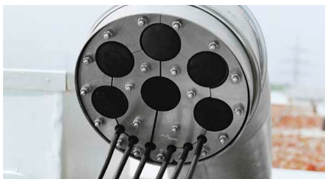
montierter Dichteinsatz SKD in Schwanenhals SHD 200
