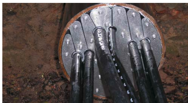
HRD 200-1G in einem Stahlrohr
