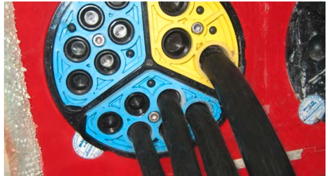
HSI 150 – SEGMENTO – mit integrierter Drehmomentkontrolle und Blindstopfen
