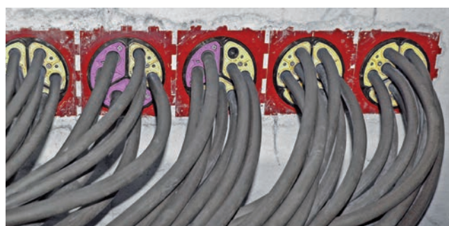
Kabelzug durch HSI-Dichtpackungen mit SEGMENTO-Systemeinsätzen
