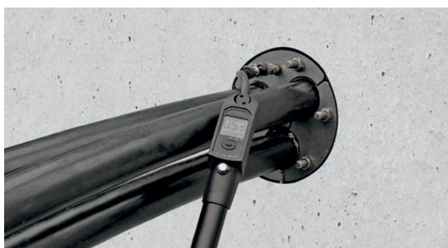
HRD 150-PVG in Kernbohrung
