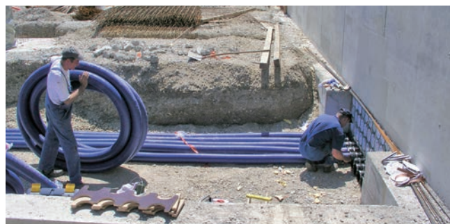
Verlegung Kabeleinführungssystem KES-M 150 mit Manschettentechnik
