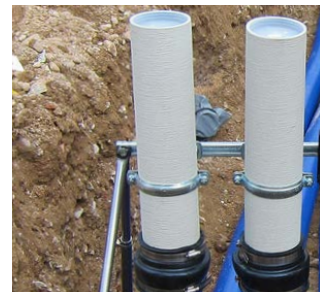
Reihenanzordnung 2x KES-M 150-ZVR 150/500 an der Aufstellvorrichtung KES-M ZVR-FUBO-Fix
