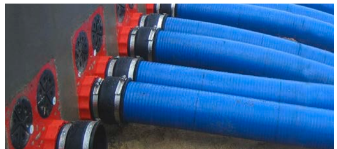
Anschluss des Kabeleinführungssystems KES-M 150
