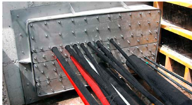
Geteilter Rechteck-Flansch mit Mehrfachbelegung
