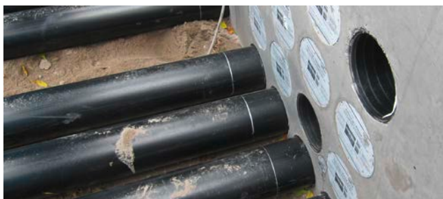
HSI 150-GSM Varia als Paket eingesetzt
