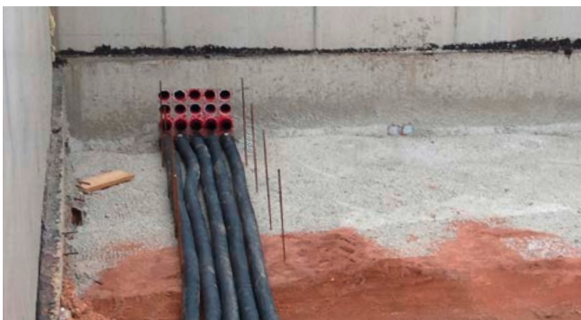
Wellrohranschluss HSI 90-D75 KS
