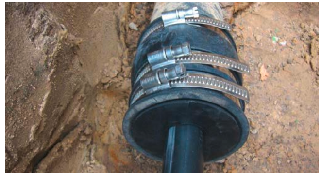
Abdichtset KES-M 90-WE100-SG-1/18-65 zur Kabelabdichtung am Ende des Kabelschutzrohres
