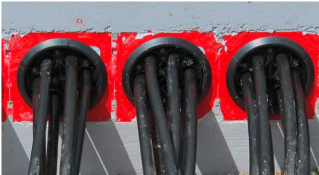
Abdichtung von Niederspannungskabeln mit HSI 150-DG-6/10-36
