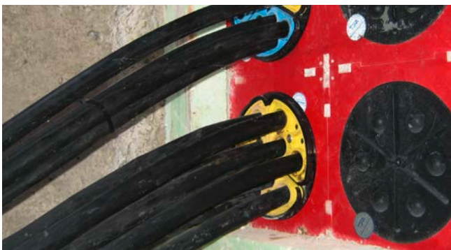
Abdichtung von Kabeln für Straßenbeleuchtung mit SEGMENTO
