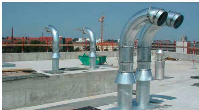
montierte SHD 200 vor Verlegung der Dachabdichtung
