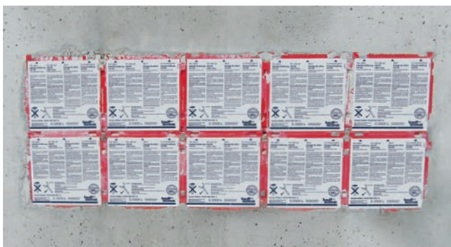
Doppeldichtpackung HSI 150 als Paket in Schalung eingesetzt
