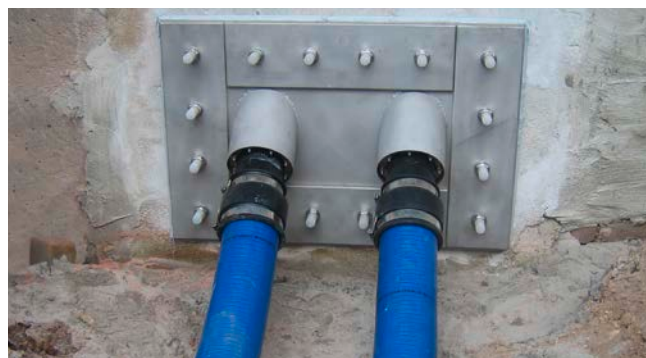
Fest-/ Losflansch mit schräger Leerrohranbindung vor Flächenabdichtung
