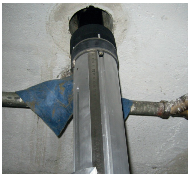
Bild 4: Hilfswerkzeug zur Montage der Außenabdichtung
