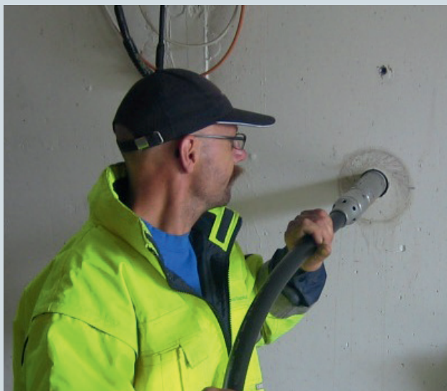
Bild 2: Start der „Rakete“ von der Gebäudeinnenseite
