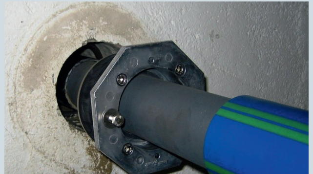
Bild 6: Montage der Innenabdichtung mit Achtkantprofil
