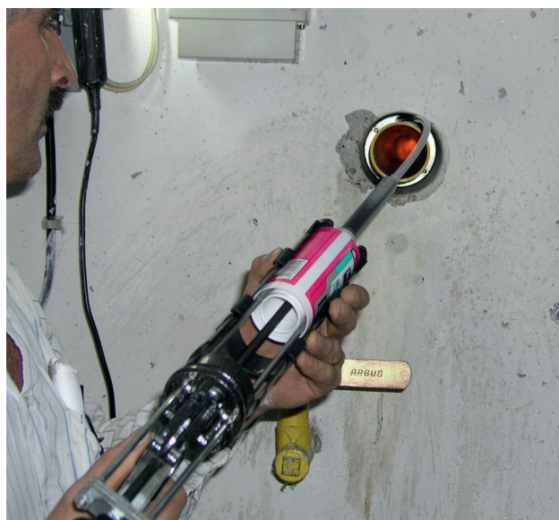
Bild 5: Zwei-Komponenten-Expansionsharz wird eingeleitet
