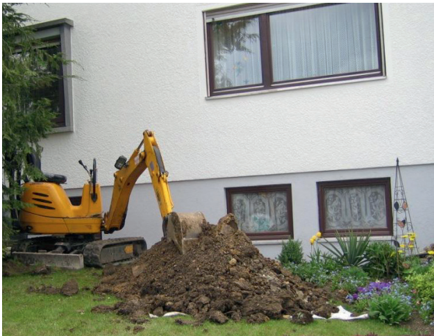
Hausanschlusserstellung mit (links) und ohne (rechts) Tiefbauarbeiten auf dem Kundengrundstück
