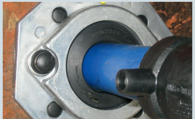
Bild 7: Innenabdichtung Wasserhausanschluss
