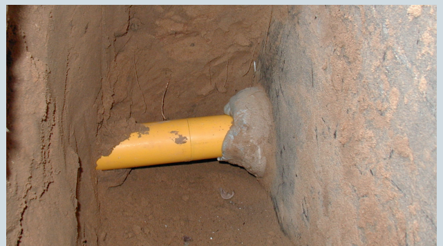
Bild 8: Kontrollaufgrabung Außenabdichtung
