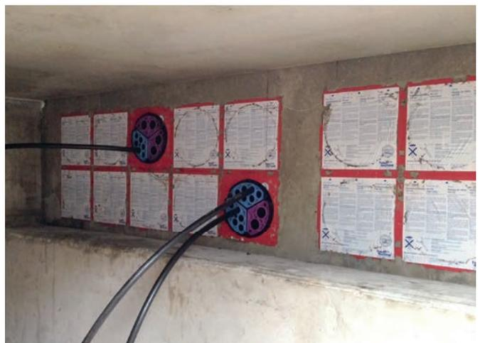
Kabelabdichtung mit SEGMENTO vom Kabelzugschacht zum Technikgebäude.
