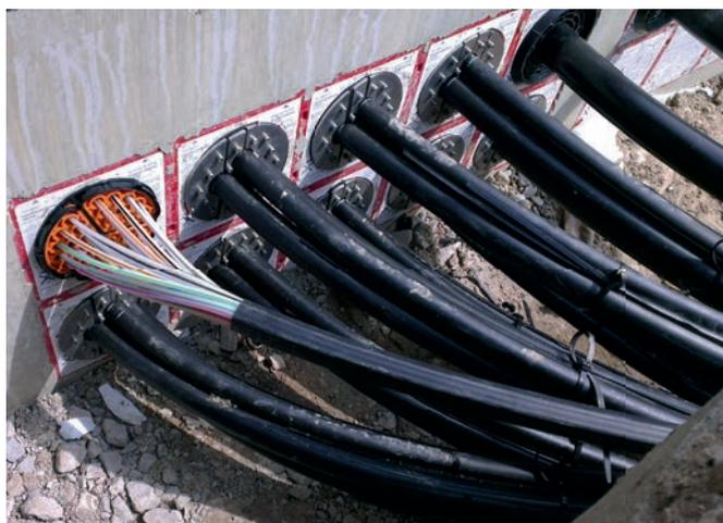
Die Abdichtung der Mikrorohre erfolgt mit SEGMENTO (oben links) sowie der Kabel und Leerrohre mit der Ringraumdichtung HRD 150/160.
