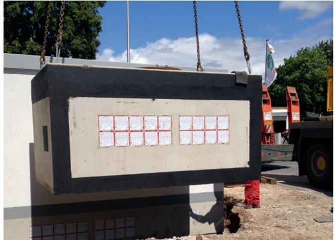
Setzen eines Kabelzugschachtes mit Autokran
