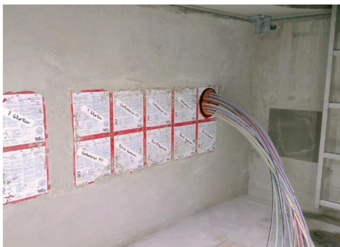
Abdichtung von Mikrorohren im Kabelzugschacht mit SEGMENTO.
