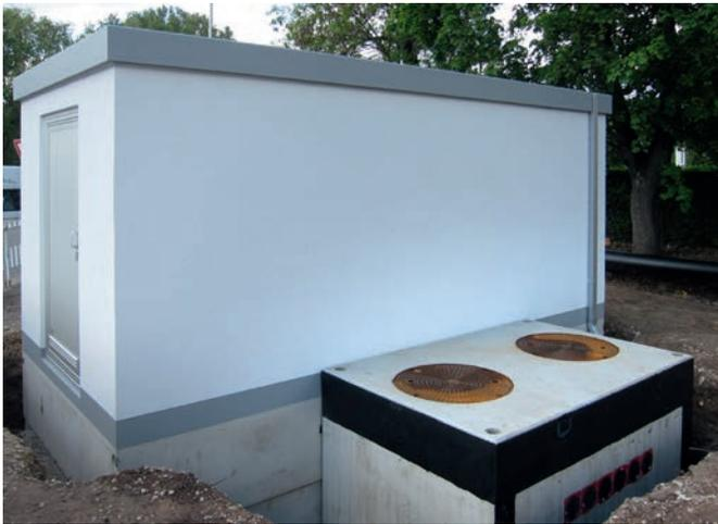
Die Anschlüsse an das Technikgebäude erfolgen über zwei Kabelzugschächte.
