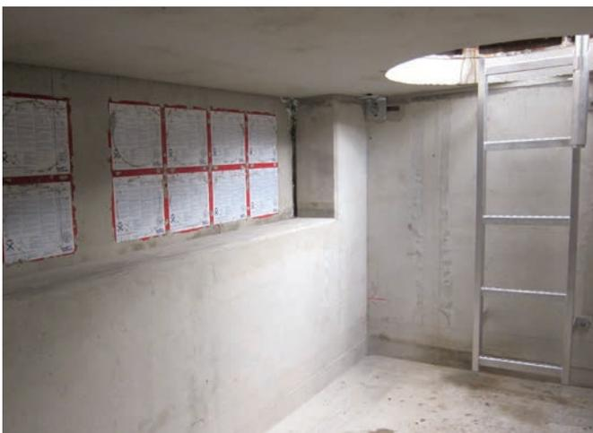
In den Kabelzugschächten sind Aussparungen für die Kabeldurchführungen vorgesehen.
