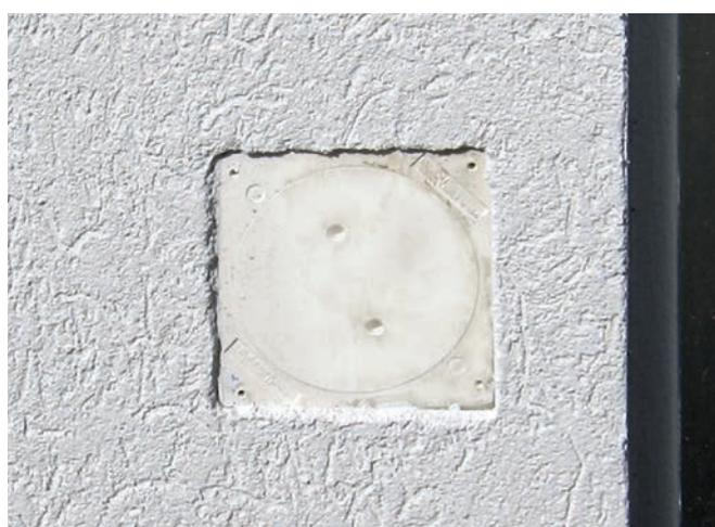
Durch die Baustromdurchführung BD 90 können Kabel elektrischer Geräte verlegt werden, die außerhalb des Technikgebäudes betrieben werden, wobei die Tür des Technikgebäudes geschlossen bleiben kann.
