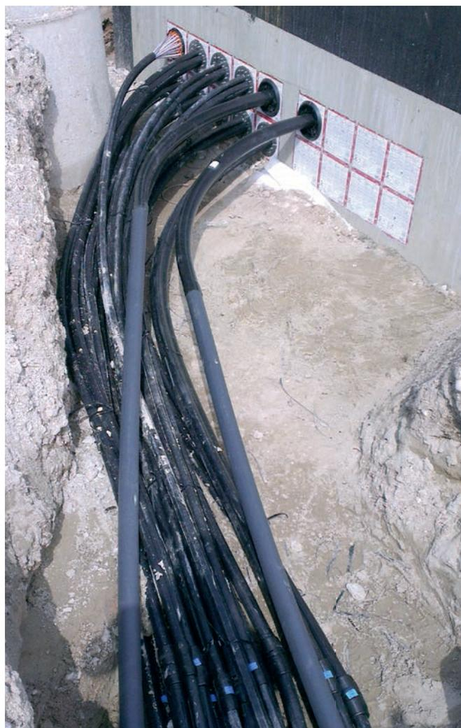
Anschluss von Leerrohren, Kabeln und Mikrorohren an den Kabelzugschacht.
