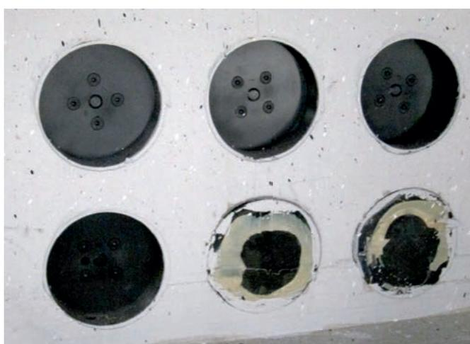
Die HSI 150-K (Wandstärke 70 – 150 mm) wird mit einem Sicherheitsdeckel ausgeliefert (Reihe oben), der erst unmittelbar vor der Kabelverlegung entfernt wird.
