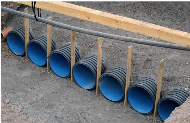
Verlegung der Leerrohre in Magerbeton
