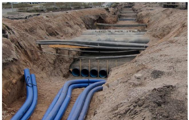
Zusätzliche PE-Leitungen DN 50 für die Kommunikation
