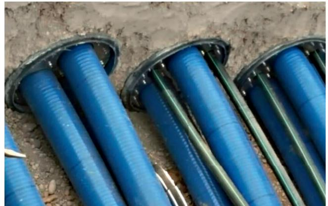
Sanddichter Verschluss der Leerrohrtrasse mit HRD-Dichtungen
