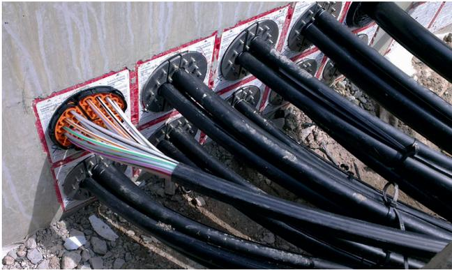
Die Abdichtung der Mikrorohre erfolgt mit SEGMENTO (oben links) sowie der Kabel und Leerrohre mit der Ringraumdichtung HRD 150/160.
