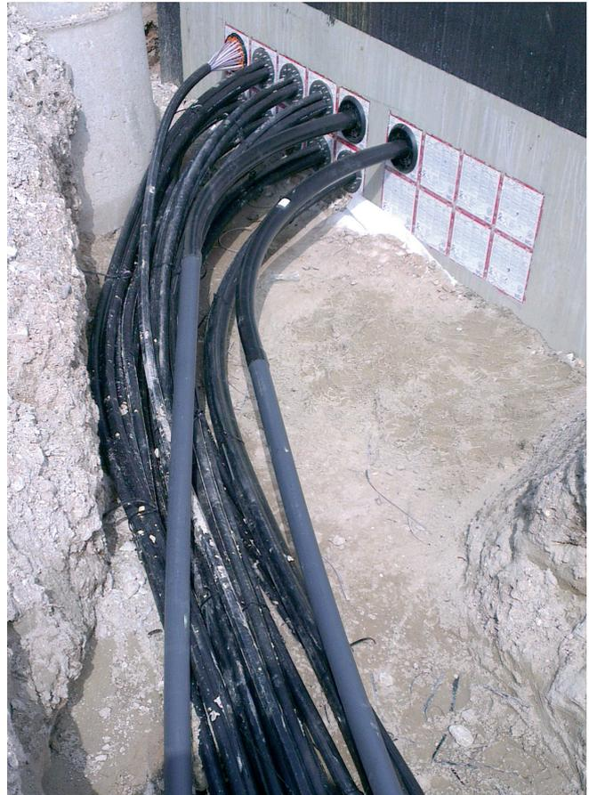
Anschluss von Leerrohren, Kabeln und Mikrorohren an den Kabelzugschacht.
