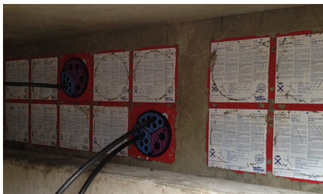
Sellado de cables con SEGMENTO desde la canaleta de cables hasta el edificio técnico.
