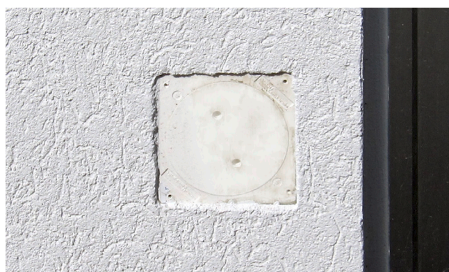
Con el pasamuros para obras BD 90 se pueden tender cables para aparatos eléctricos que funcionan en el exterior del edificio técnico, de modo que la puerta del edificio técnico puede permanecer cerrada.
