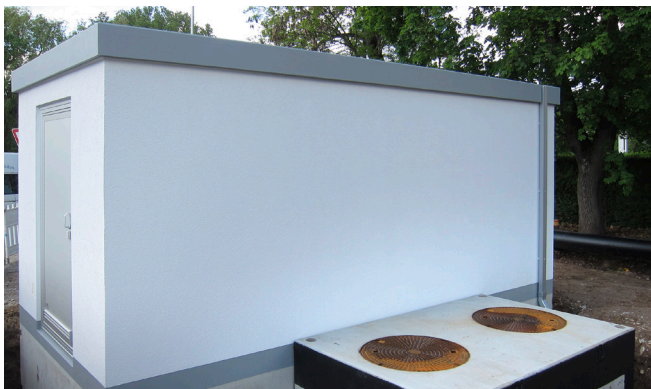
Las conexiones con el edificio técnico se realizan a través de dos pozos de cables.
