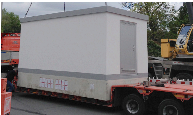
Entrega del edificio técnico
