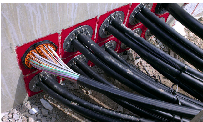
Los microtubos están sellados con SEGMENTO (arriba a la izquierda) así como los cables y conductos con la junta anular HRD 150/160.
