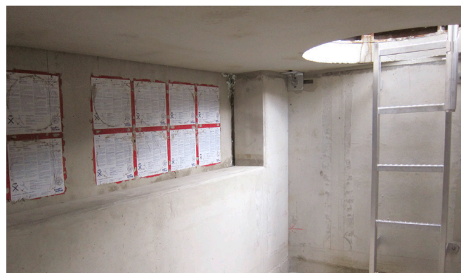
Los huecos para los pasacables están previstos en los pozos de cables.
