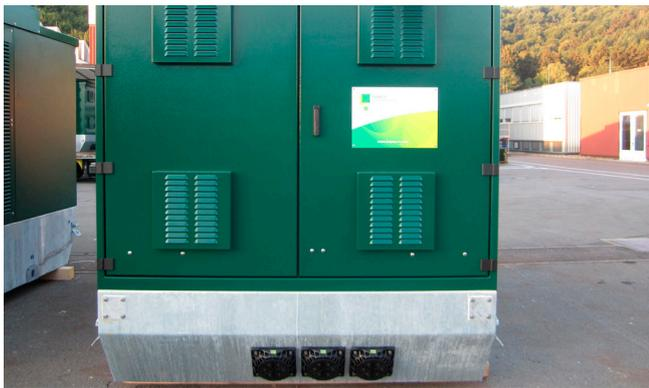
Debido al ligero diseño donde se ha utilizado chapa metálica en lugar de hormigón, las estaciones de transformación pueden ser transportadas por grandes camiones desde Alemania al sur de España.
