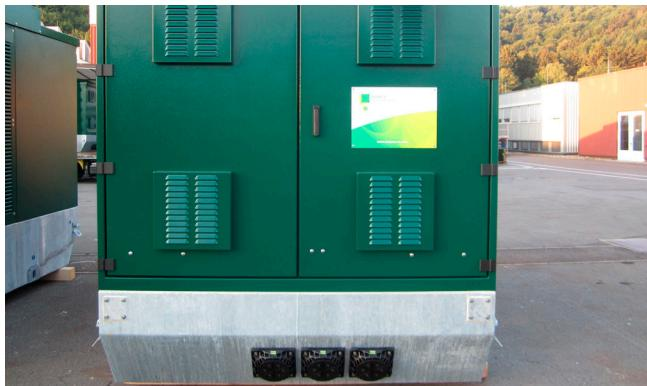
Trafostanice imaju laku konstrukciju zahvaljujući obradi limenog dna, umjesto betonske varijante, pa ih je stoga moguće transportirati tegljačem iz Njemačke do južne Španjolske.
