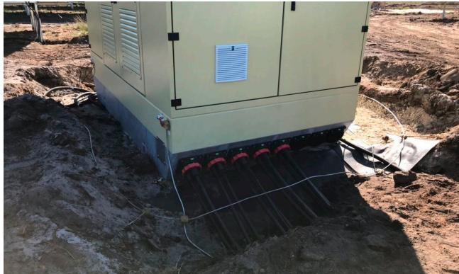
Ovisno o kapacitetu pojedinačnih stanica i količini potrebnih kabela, upotrebljava se više kabelskih uvoda. Zahvaljujući kompaktnoj konstrukciji prigradne prirubnice moguće je ugraditi najviše 7 komada u nizu na dno kućišta stanice. Montaža isporučenog brtvenog elementa HSI 150-D3/58 te brtve kabela obavlja se na licu mjesta.
