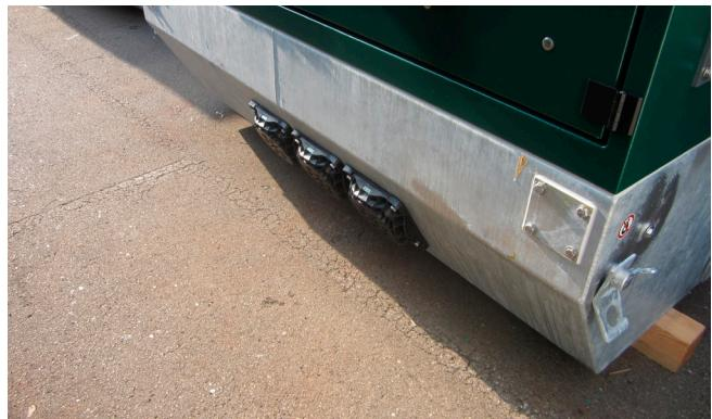
Prigradnu prirubnicu HSI 150-DFK već je montirao proizvođač stanice te je zatvorena slijepim brtvenim poklopcom HSI 150-D. Za montažu prirubnice na metalno dno kućišta upotrebljavaju se vijci za lim (postavljaju se na gradilištu u skladu s debljinom materijala od kojeg je izrađeno dno kućišta).
