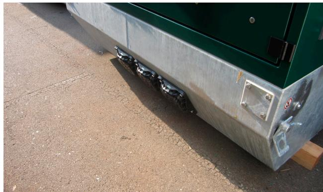
Le flange HSI 150-DFK sono state premontate dal produttore della stazione e chiuse alla cieca con la copertura di sistema HSI 150-D. Per il montaggio della flangia sul fondo dell'alloggiamento in metallo sono state utilizzate delle viti autofilettanti (a seconda dello spessore del materiale che costituisce il fondo dell'alloggiamento, inserite in opera).
